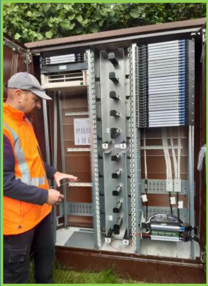
ARMOIRE DE REPARTITION FIBRE HAUT-DEBIT MANSPACH/ALTENACH
